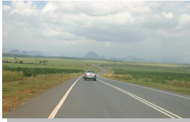
Rajah 13: Jalan paved / berturap
